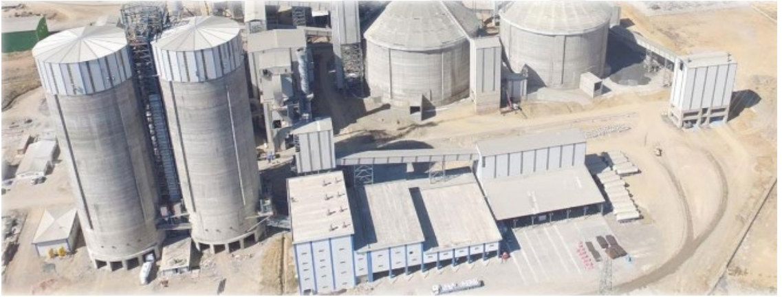
Şekil 13. Üretilen çimentoların depolandığı silolar ve paketleme ünite tesisi
