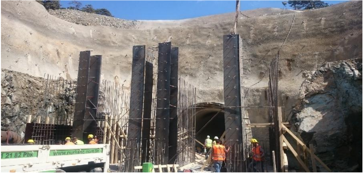
Şekil 3.12: Derivasyon Tüneli Çalışması
