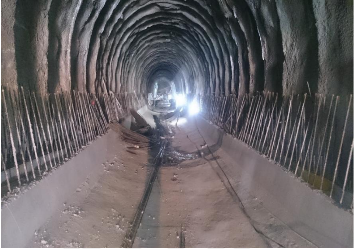
Şekil 3.13: .Derivasyon Tüneli Çalışması
