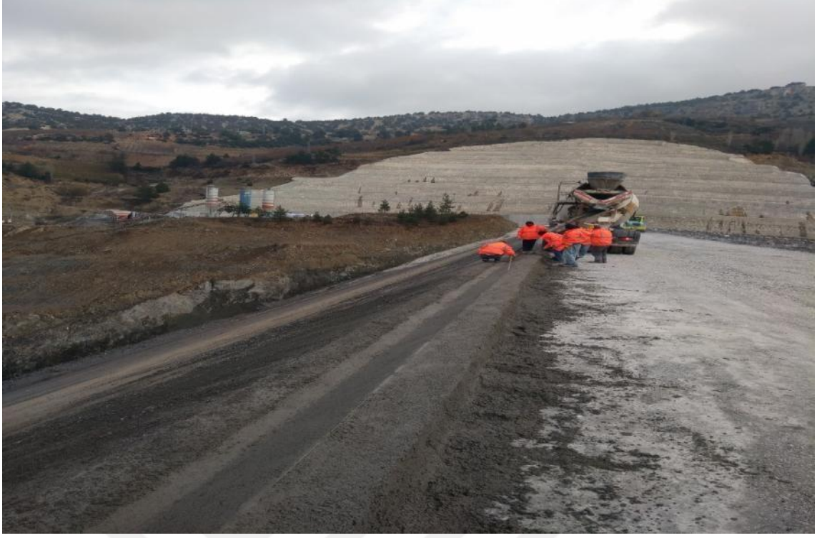
Şekil 3.9: Baraj Gövdesi Ön Yüzü B.A Betonü Çalışması
