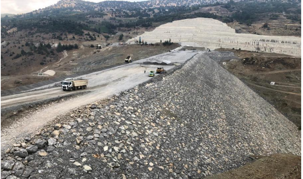
Şekil 3.4: Baraj Gövde Dolgu Çalışması
