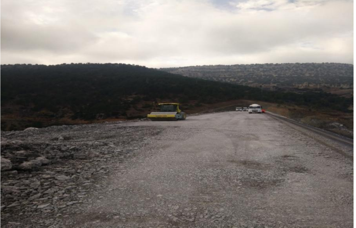
Şekil 3.8: Baraj Gövde Dolgusu ( Silindir ile Sıkıştırma İşlemi)
