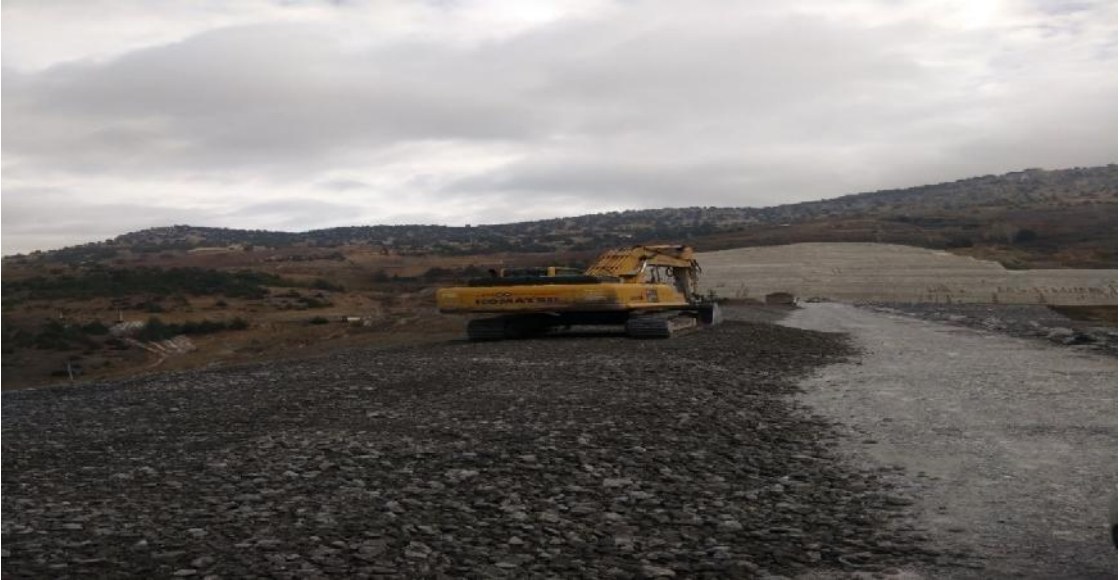
Şekil 3.6: Baraj Gövde Dolgu Çalışması (Dolguya 3A-3B-3C-3D Malzeme Serimi)
