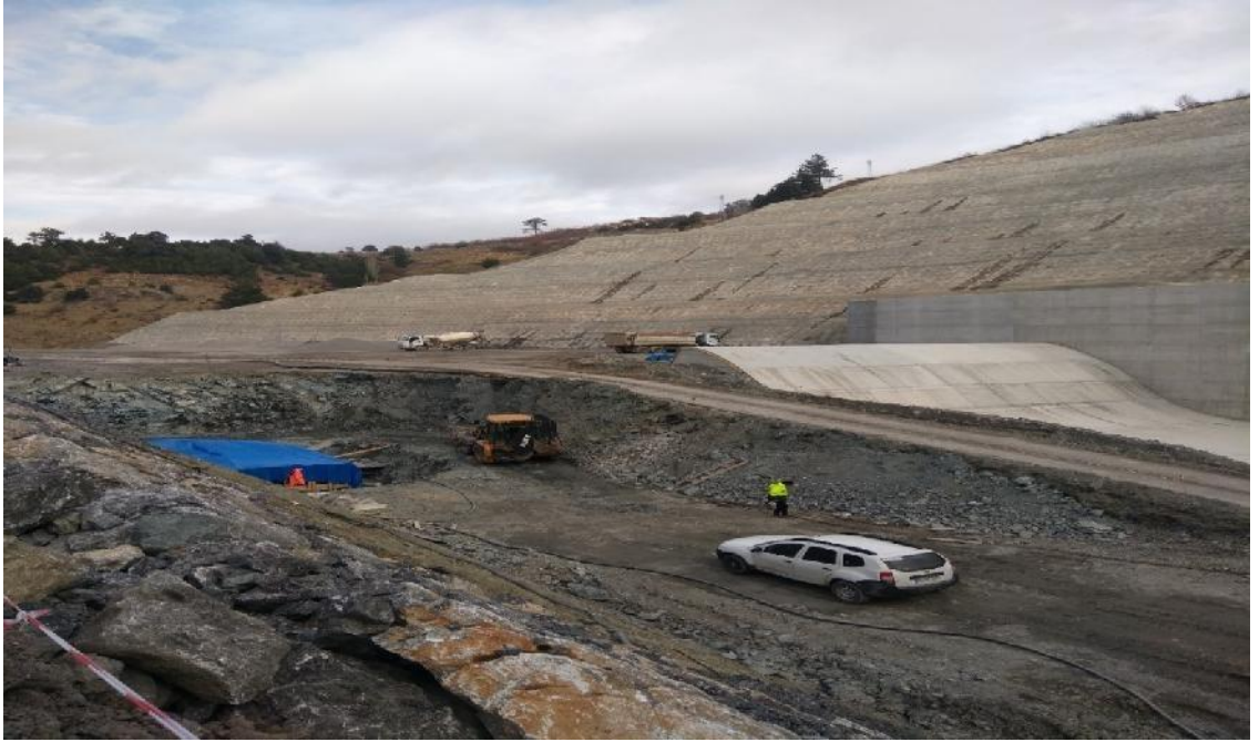
Şekil 3.10: Dolusavak Çalışması
