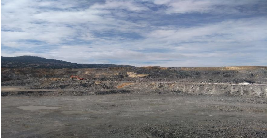
Şekil 3.14: Kaya Ocağı Çalışması ( Ekskavatör )
