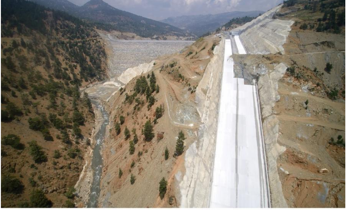
Şekil 3.11: Dolusavak Çalışması
