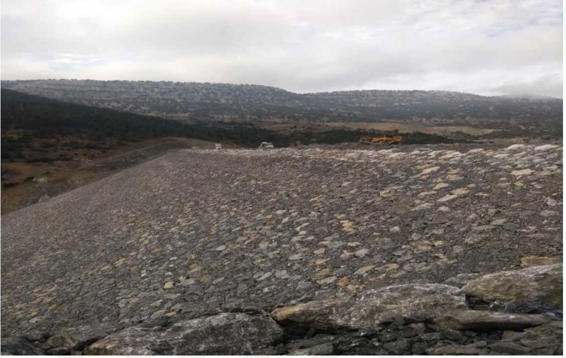
Şekil 3.5: Baraj Gövde Dolgu Çalışması (Kaya Malzemesi ile Riprap Yapımı)
