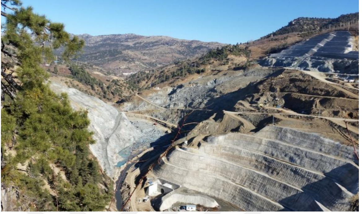
Şekil 3.3: Baraj Gövde Sıyırma Kazı Çalışması
