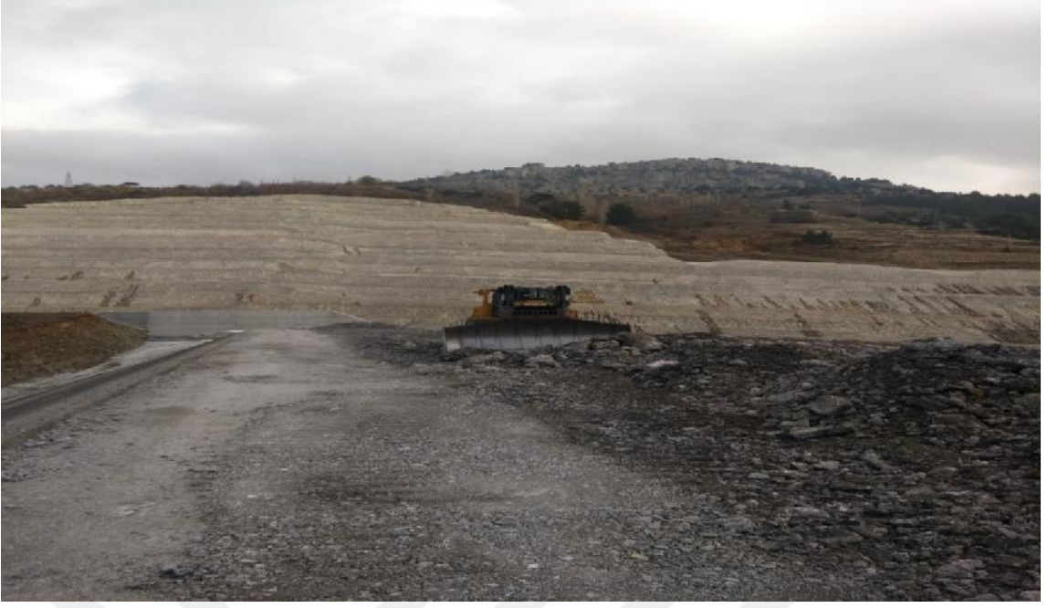
Şekil 3.7: Baraj Gövde Dolgusu ( Paletli Dozer ile Malzeme Serimi)
